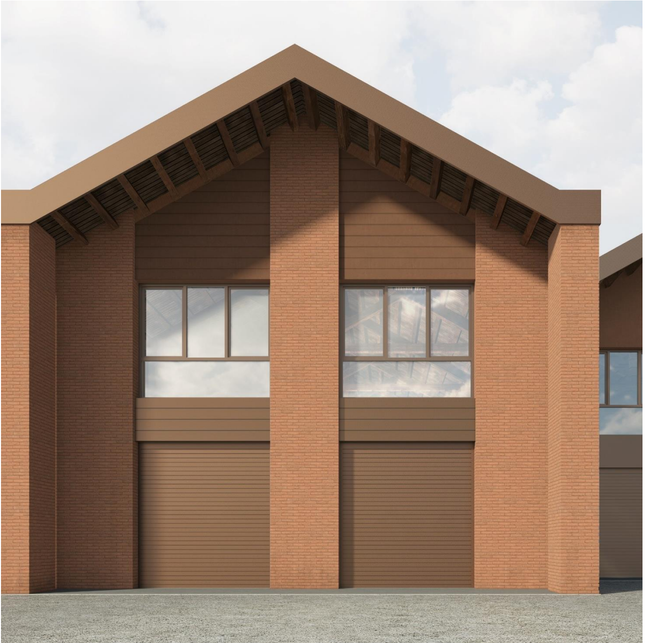
Dettaglio della facciata sul fronte lagunare
