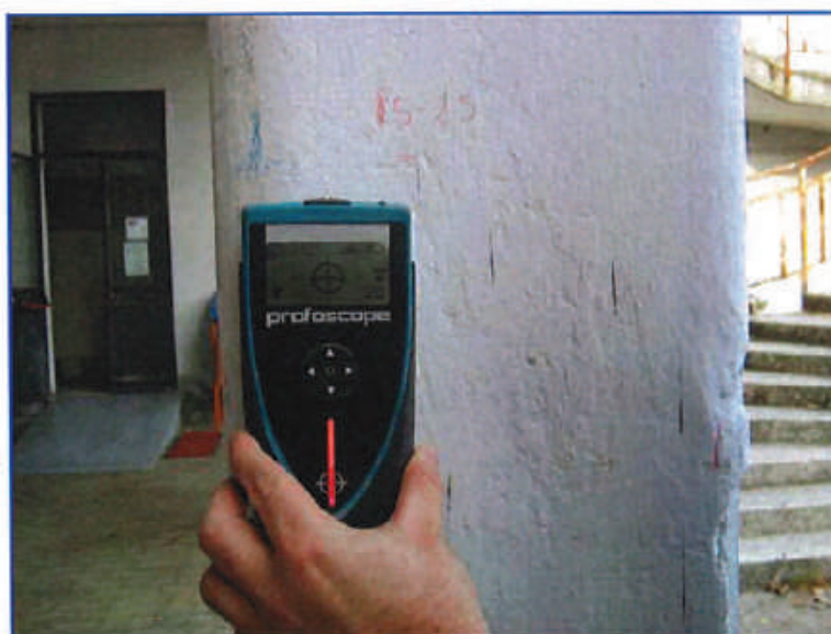
Indagine pachometrica su pilastro
