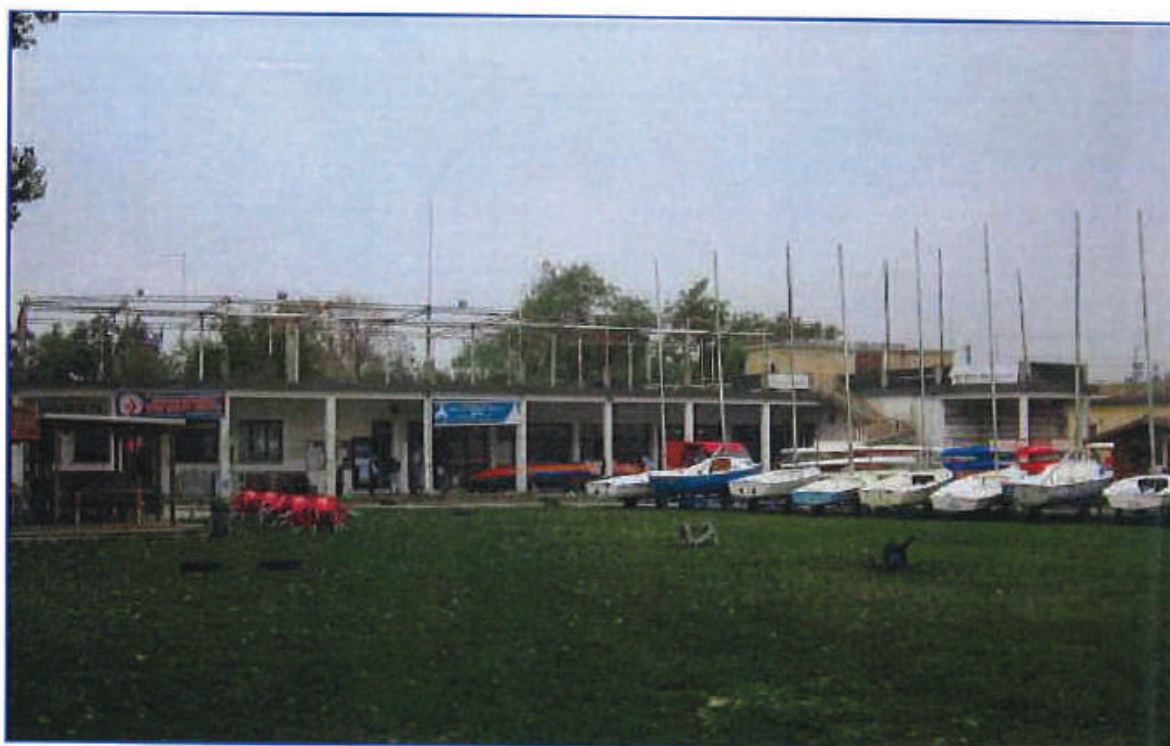
Vista frontale dell'edificio "Ex Colonia"
