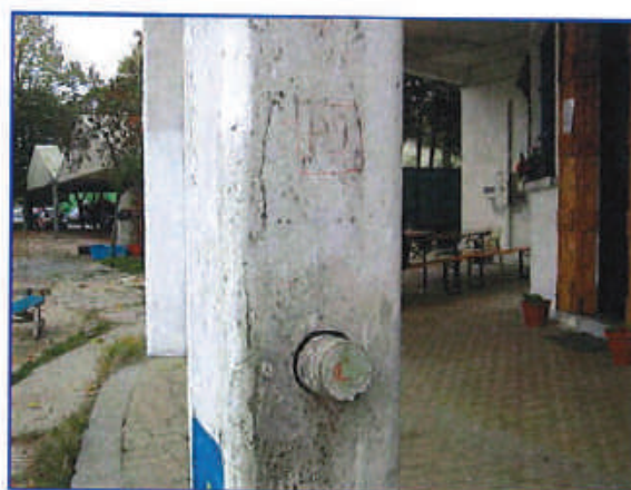
Provino C su Pilastro P9
