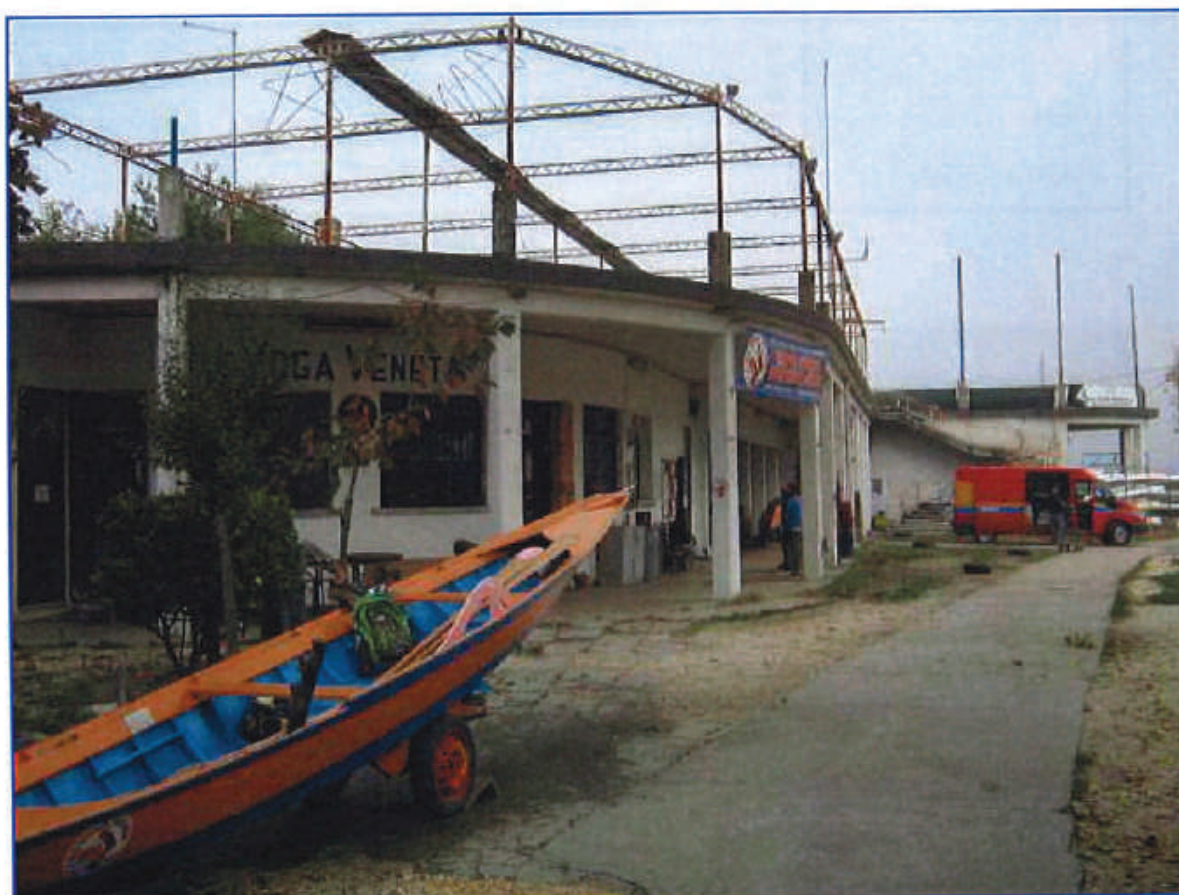
Edificio "Ex Colonia"
