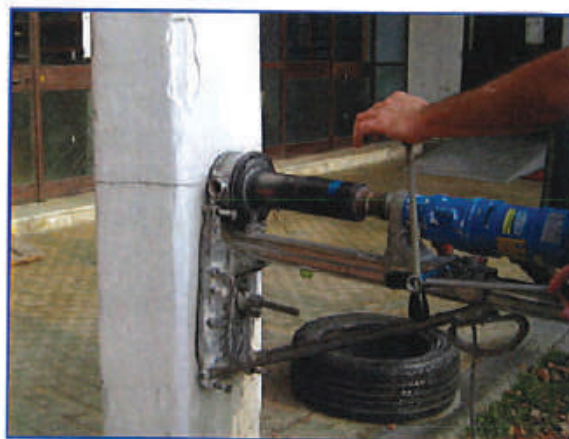
Esecuzione carotaggio su pilastro
