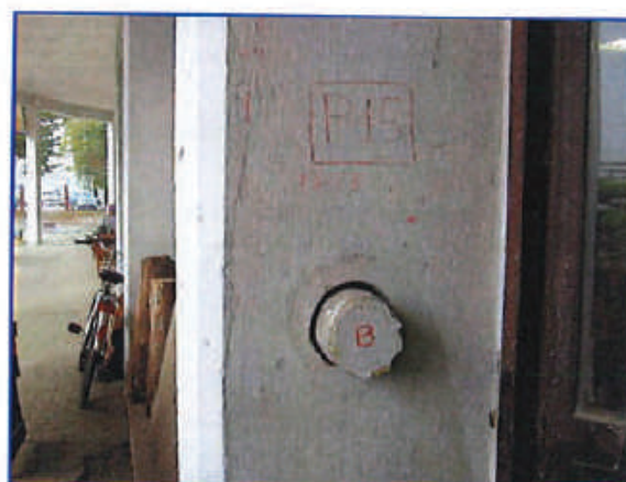
Provino B su Pilastro P15
