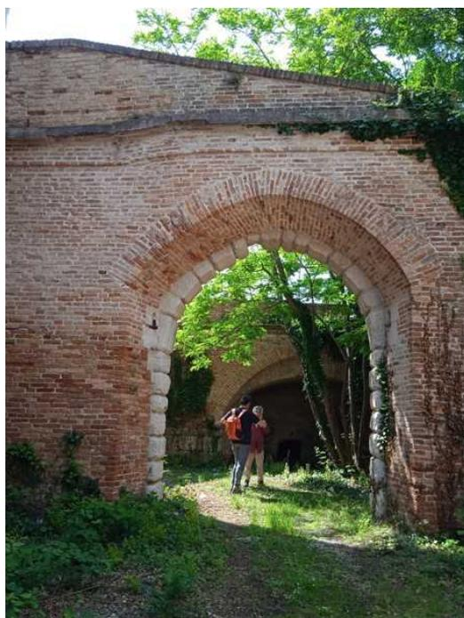
Passati sotto l'arcone rampante ci rendiamo conto di quanto sia irregolare la sua volta probabilmente frutto di una ricostruzione risalente al 1929 da parte di maestranze non all'altezza delle competenze e capacità di quelle del XVI secolo. Nota 1
