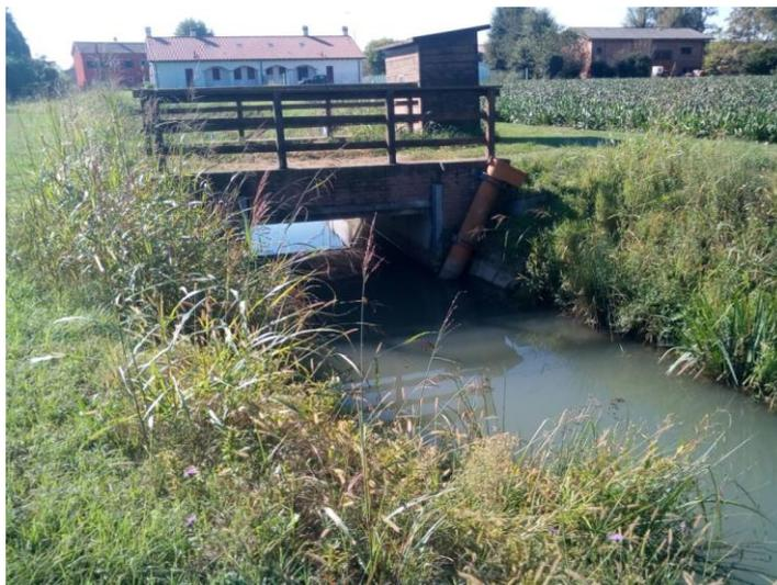
c'è un galleggiante che, se il livello d'acqua dello scolo è troppo alto, fa scattare il dispositivo di abbattimento della paratoia per consentire il veloce deflusso delle acque.
