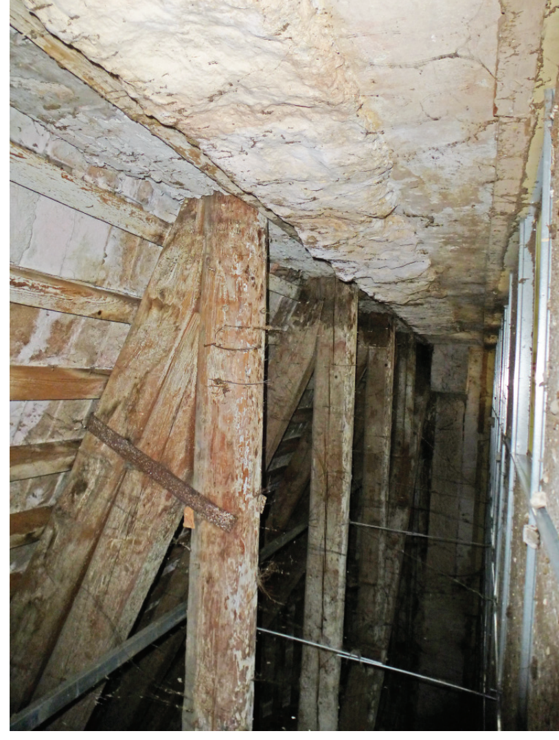
VISTA DEL SOTTOTETTO - ATTACCO CAPRIATE ALLA MURATURA
