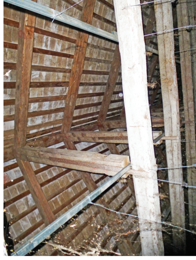
VISTA DEL SOTTOTETTO - CAPRIATE LIGNEE
